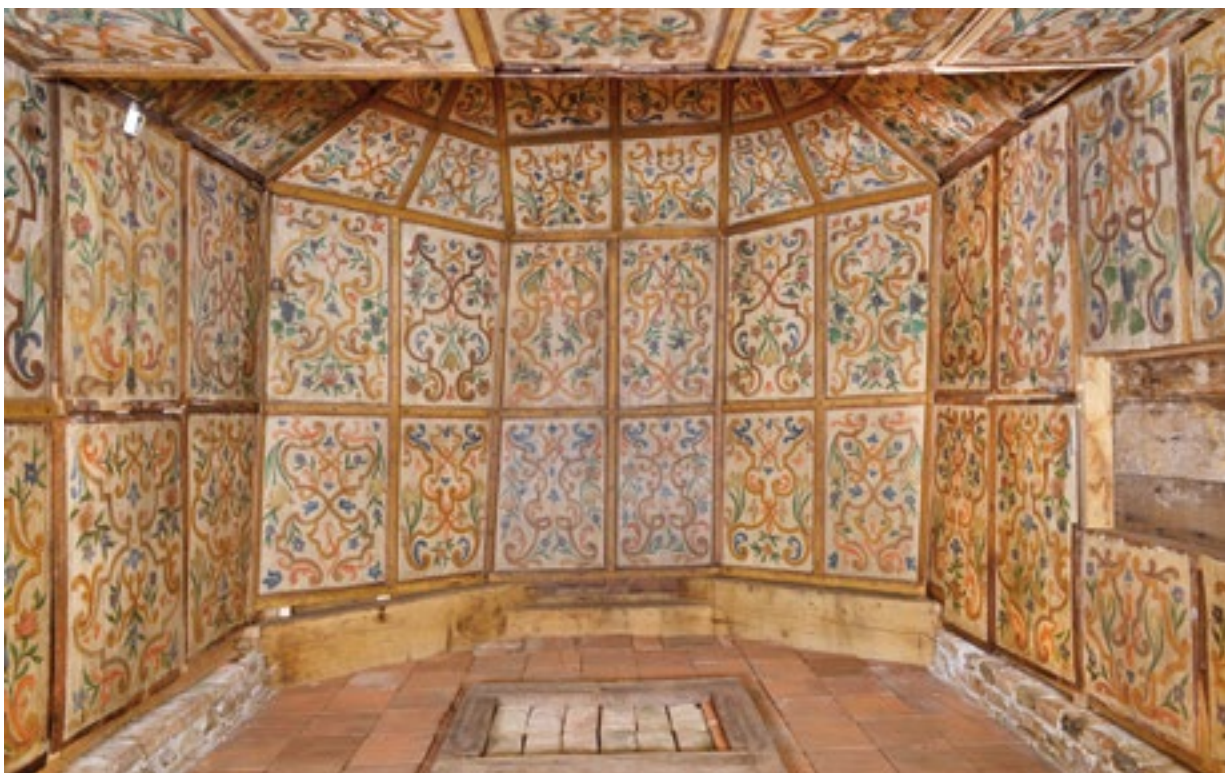
14. Pogled na svetište nakon montaže restaurirane oslikane drvene oplate (fototeka HRZ-a, snimila N. Oštarijaš, 2015.)
