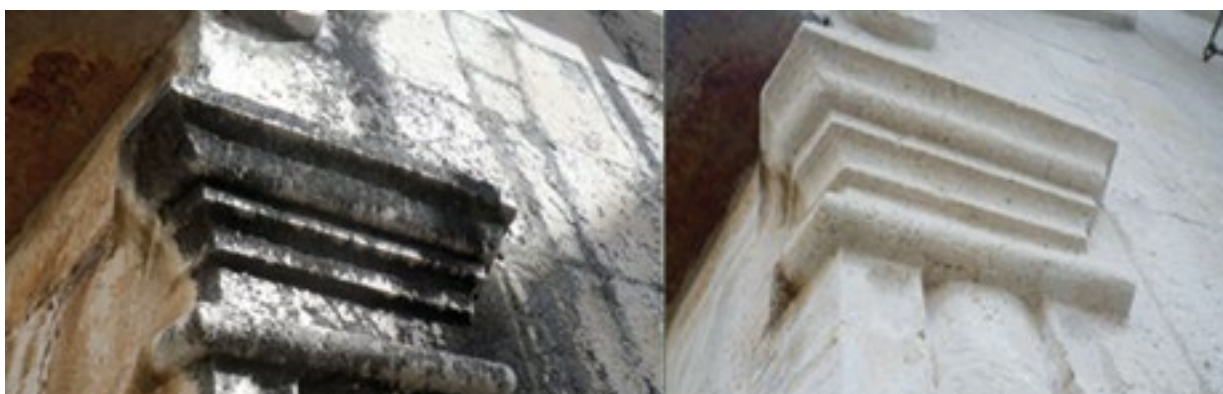
7. Detalj pilastra s glavnog pročelja crkve, prije restauratorskog zahvata, 2011.; detalj pilastra s glavnog pročelja crkve nakon restauratorskog zahvata, 2015. (snimila L. Krstulović Buzolić)
