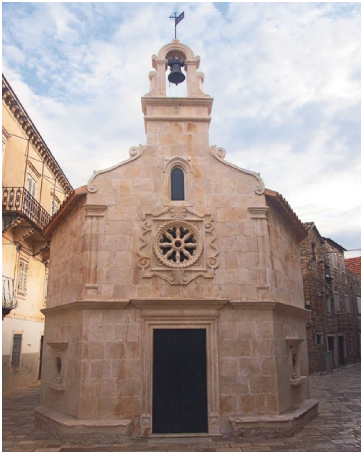
23. Zapadno pročelje crkve sv. Ivana u Jelsi nakon zaštitnih radova (snimila M. Plenković, 2016.) West front of St. John's Church in Jelsa, after protection works (photo by M. Plenković, 2016)
