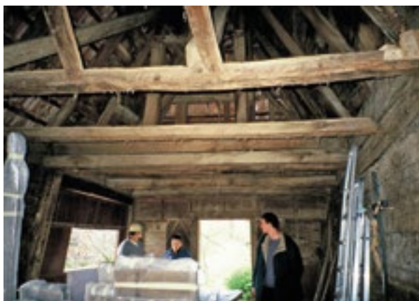
9. Unutrašnjost kapele tijekom demontaže oplata (fototeka HRZ-a, snimio D. Ivić, 2002.)
