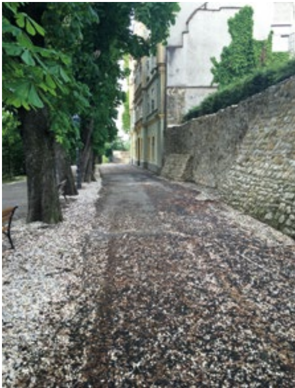
15. Saniran i rekonstruiran bedem na Strossmayerovu šetalištu (snimio M. Hrzić, 2016.)
