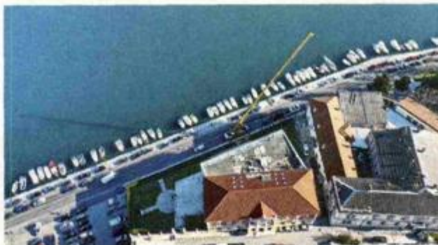
Do završetka radova na Poluotoku je važila privremena regulacija prometa
