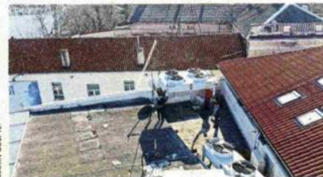
Radovi na obnovi sustava grijanja i hlađenja u Muzeju antičkog stakla
